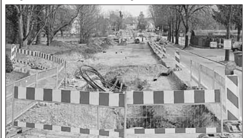
Wegen der Erneuerung von Versorgungsleitungen bleibt die Schaffhauser Straße in beiden Richtungen für zwei bis drei Wochen gesperrt.
