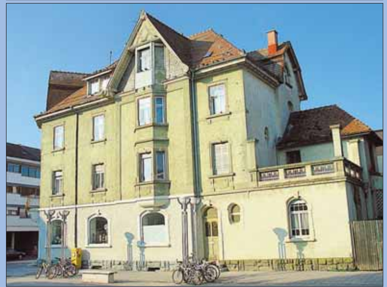
Gegenwart und Zukunft: Das Foto zeigt die Ostansicht des ehemaligen „Café National“ vom Heinrich-Weber-Platz aus; darüber der Plan der Südsansicht des zukünftigen „Nats“, von der Freiheitstraße her betrachtet. Neben dem bereits bestehenden Kiosk auf dem Heinrich-Weber Platz und dem Münchow-Areal wird das neue „Nats“ die Konzeption des Heinrich-Weber-Platz“ abrunden.
