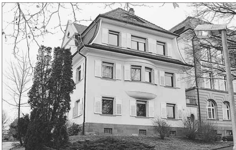
Neue Nutzung am Hegau-Gymnasium: Wo bisher im Erdgeschoss des denkmalgeschützten Anbaus die Hausmeisterwohnung untergebracht war, finden die Schülerinnen und Schüler bald ihre neue Mensa vor.
