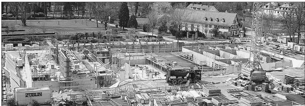
Baufortschritte an der Stadthallen-Baustelle: Die letzten Wände des Untergeschosses sind nun hergestellt – teilweise in Ortbeton und teilweise mit Halbfertigteilen. Die Decke über dem Foyer des Untergeschosses ist fertig. Darauf wird gerade die Schalung für die ersten beiden Betonierabschnitte der südlichen Foyerwand gestellt. Diese Sichtbetonwand soll einmal ca. 12 Meter hoch aufragen. Im mittleren Bereich des Kellergeschosses ist man derzeit am Flechten der Bewehrung eines Teils der Tiefgaragendecke. Am Querweg zur Schmiedstraße wurden die letzten Aushubarbeiten für die spätere Tiefgaragenausfahrt beendet. Die Stützen weisen auf den ersten Bauteil der Tiefgarage hin.
