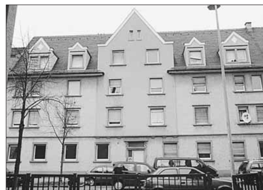
Das Haus Ekkehardstraße 97 aus dem Jahr 1928 wird von der GVV Städtische Wohnbaugesellschaft mbH komplett saniert und modernisiert.
