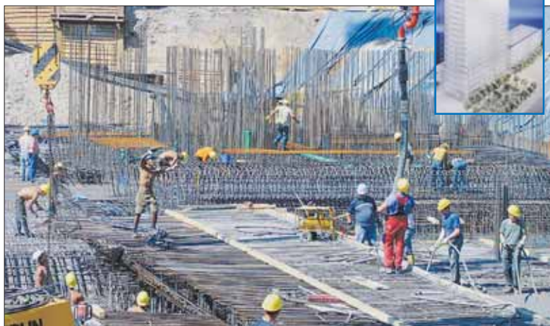
Betonierung der Bodenplatte an der Baustelle des Hegau Towers: Es wurden 1300 Kubikmeter Beton in etwa 11 Stunden verarbeitet. Vor Ort waren zwei Betonpumpen und 160 Transportfahrzeuge der Firmen Transportbeton Singen und Meichle & Mohr im Einsatz. – Wie der Hegau Tower einmal aussehen soll, das zeigt unser kleines Bild.
