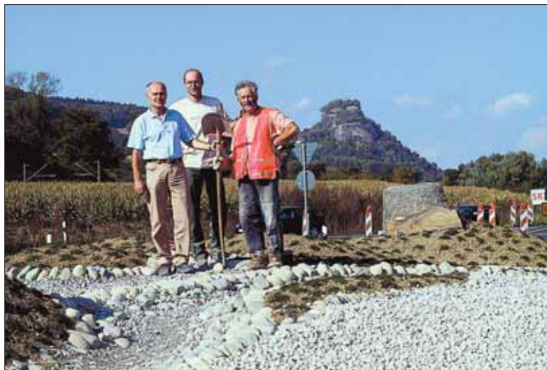
Hohentwiel und Hohenkrähen im Kleinformat: Michel Leroux aus Bodman (rechts im Bild) hatte die Idee und leistete die Handarbeit bei der künstlerischen Gestaltung des Kreisverkehrs, tatkräftig unterstützt von Dieter Rummel, Abteilung Straßenbau (links), und Christian Bold, Garten- und Landschaftsbau Bold (Mitte).
