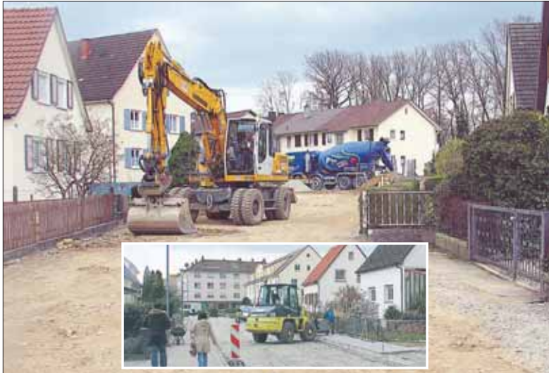
Es geht kräftig voran mit der Erneuerung von Kanal- und Leitungssystemen im Singener Süden.
