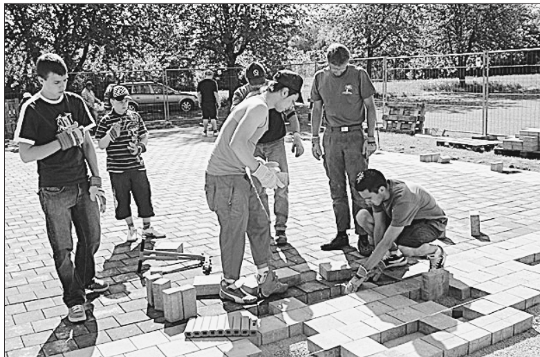
Bau der Street Soccer-Anlage in der Singener Nordstadt: Tatkräftig unterstützten zahlreiche Jugendliche unter der Anleitung von Martin Lennhart-Höss (Leiter des JuNo), Stephanie Hennes (Mitarbeiterin des JuNo) und Denzel Jung (Abteilung Stadtplanung) die Arbeiten. Trotz Pfingstferien begannen die Jugendlichen morgens um 9 Uhr, um „ihren“ Wunsch einer attraktiven Kleinfußball-Anlage verwirklichen zu können. Im letzten Jahr wurde der Wunsch nach solch einer Einrichtung von zahlreichen Jugendlichen mittels einer Unterschriftensammlung artikuliert. Durch die Einbeziehung in die Bauarbeiten soll eine erhöhte Identifikation mit der neuen Sportanlage geschaffen werden.
