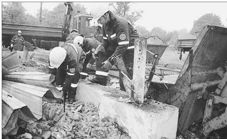
Hilfseinsatz des THW auf dem Schwärzehofer in Singen: Nun müssen die Brandreste als Sondermüll entsorgt werden.
