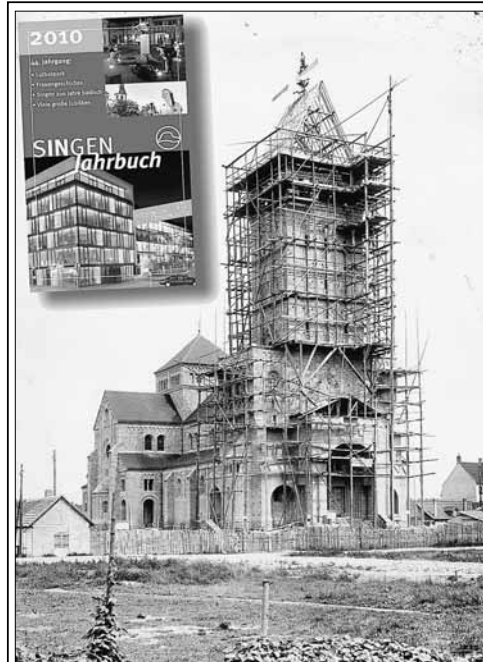
Der Rohbau der Herz-Jesu Kirche zum Zeitpunkt des Richtfestes im April 1911.
