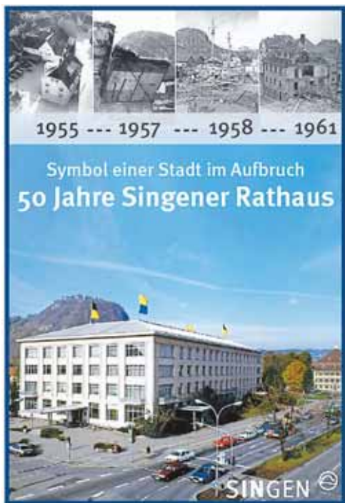
Am 12. Dezember 1955 entschied der Gemeinderat über den Bau des neuen Singener Rathauses. Vor Baubeginn mussten aber im Alten Singener Dorf 12 historische Häuser eingerissen werden, deren Bewohner und Firmen – wie Eisen-Fischer oder Konz – man umsiedelt hat. Der Startschuss zum Rathausneubau fiel am 7. Oktober 1957. Ein Jahr später wurden am 17. Oktober 1958 Richtfest und Grundsteinlegung gefeiert. – Mehr dazu in der Broschüre „Symbol einer Stadt im Aufbruch – 50 Jahre Singener Rathaus“, versehen mit zahlreichen historischen Fotos (für 2 Euro im Stadtarchiv Singen, DAS 2, Julius-Bührer-Straße 2, Zimmer 11, erhältlich).
