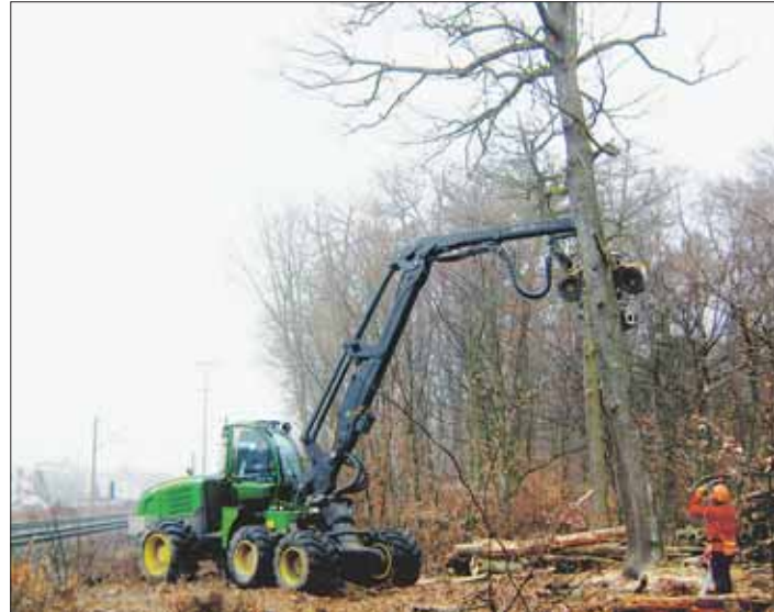
Die Rodungsarbeiten für die Mittelspange zwischen der Bahnlinie und der B34 sind abgeschlossen. Im Herbst soll mit den Bauarbeiten für die Brücke über die Gleise begonnen werden.
