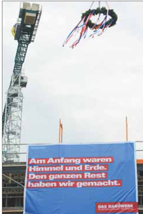
Im kleinen Rahmen mit 50 Handwerkern hat die Handwerkskammer Konstanz das Richtfest der neuen Bildungsakademie in Singen gefeiert. Ab Frühjahr 2012 nimmt die moderne Bildungsrichtung den Betrieb auf.
