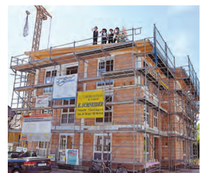
Die Bauarbeiten schreiten bestens voran. Ende September/Anfang Oktober soll das Sozialzentrum bezogen werden können. swb-Bild: cb
