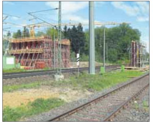
Die Arbeiten an der Brücke über die Deutsche Bundesbahn im Zuge der Mittelspange sind im vollen Gange. Das Widerlager Nord und die Mittelstütze wurden bereits betoniert. Zurzeit erstellt man die Schalung und die Bewehrung für das südliche Widerlager. Die Pafenhäule ist wegen der Brückenbauarbeiten im Bereich der Robert-Gerwig-Straße für den Verkehr gesperrt. Auch Fußgänger dürfen die Baustelle aus Sicherheitsgründen nicht betreten.
