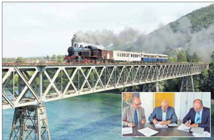
Die Museumsbahn kann nun über die fast 15 Kilometer lange Strecke und die Stahlbrücke (im Stile Eifels) über den Rhein bei Hemishofen nach Singen und von dort auch weiter auf die Sauschwänze Bahn rollen (großes Bild). Sie haben den Pachtvertrag unterzeichnet (kleines Bild): Bürgermeister Bernd Häusler, Giorgio Behr, Präsident der gemeinnützigen Stiftung Museumsbahn, und Vizepräsident Christoph Brändli. Damit ist der Weg frei für die Museumsbahn.
