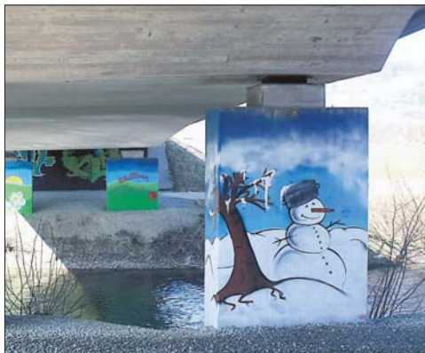
Solche legalen Graffitis wie hier an der Aach-Brücke entlang machen Spaß und bringen Farbe auf grauen Beton. Illegales „Schmierereien“ hat die Stadtverwaltung den Kampf angesagt.
