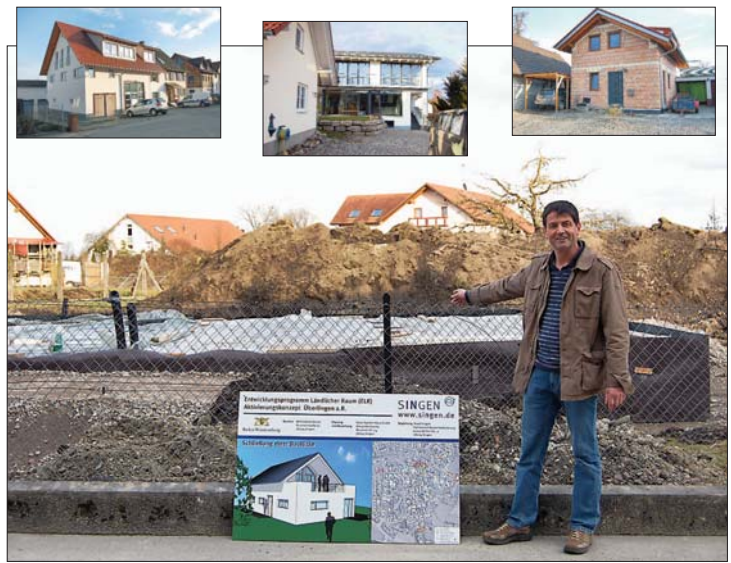
Das aktuelle ELR-Projekt in Überlingen am Ried: Wilfried Handloser vor der Baustelle seines Einfamilienhauses in der Brunnenstraße 27 (großes Bild). Weitere geförderte Neubauten (kleine Bilder, von links) befinden sich in der Hårdlestraße, Bohlstraße und Bergstraße.
