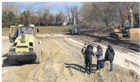
Die Arbeiten am neuen Kunstrasenplatz sind bereits weit fortgeschritten. Aufgrund der Lage des Sportplatzes auf einer Deponie waren bei der Planung und sind jetzt beim Bau ungewöhnliche technische Herausforderungen zu meistern. swb-Foto: Stadt Singen
