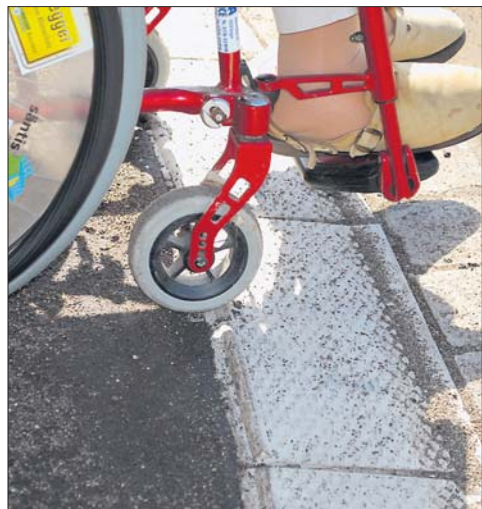
Klein aber fein: Die neuen Rollbords an der Straßenüberquerung Bruderhofstraße/Einmündung „Am Posthalterwäldle“ sind mit einer Nut ausgestattet. Sie verhindert, wie hier am kleinen Rad zu sehen, dass Rollstuhlfahrer oder Senioren mit dem Rollator unbeabsichtigt auf die Straße rollen.
