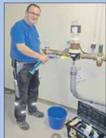
Gerd Heizmann ist für Installationen zuständig.
