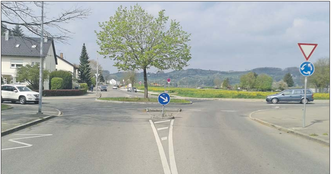
Die Umbauarbeiten am Kreisell an der Bruderhof-/Hohenhewen-/Max-Porzig-Straße haben inzwischen begonnen.
