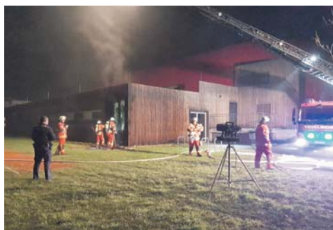
Unter Atemschutz mussten die brennenden Fassadenteile an der neuen Engener Stadthalle gelöscht werden. swb-Bild: jfw Engen
