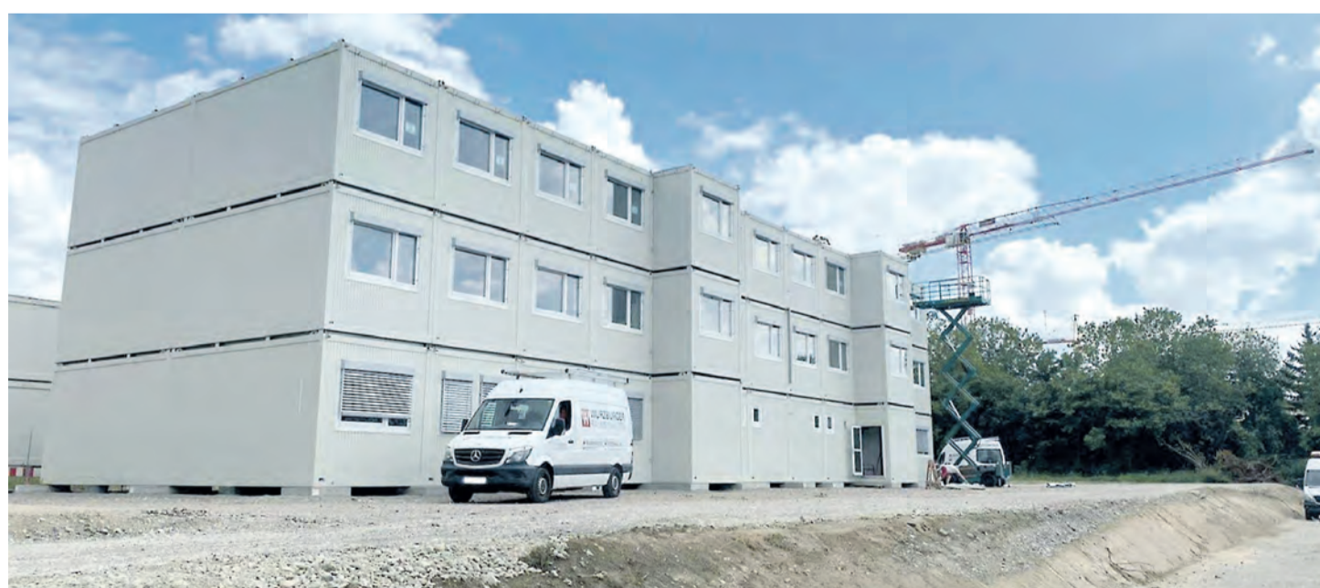
Eine Containersiedlung wie diese soll im Steißlinger Gewerbegebiet bis zum Herbst als Unterkunft für die Geflüchteten entstehen. Der Gemeinderat vergab das Projekt für 1,1 Millionen Euro in seiner vergangenen Sitzung
